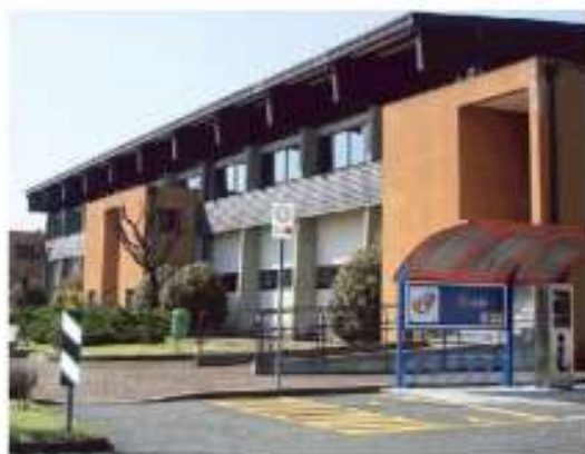
Il centro polisportivo del Geirino, al centro di un piano di salvataggio
