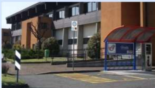
Il centro polisportivo del Geirino, al centro di un piano di salvataggio
