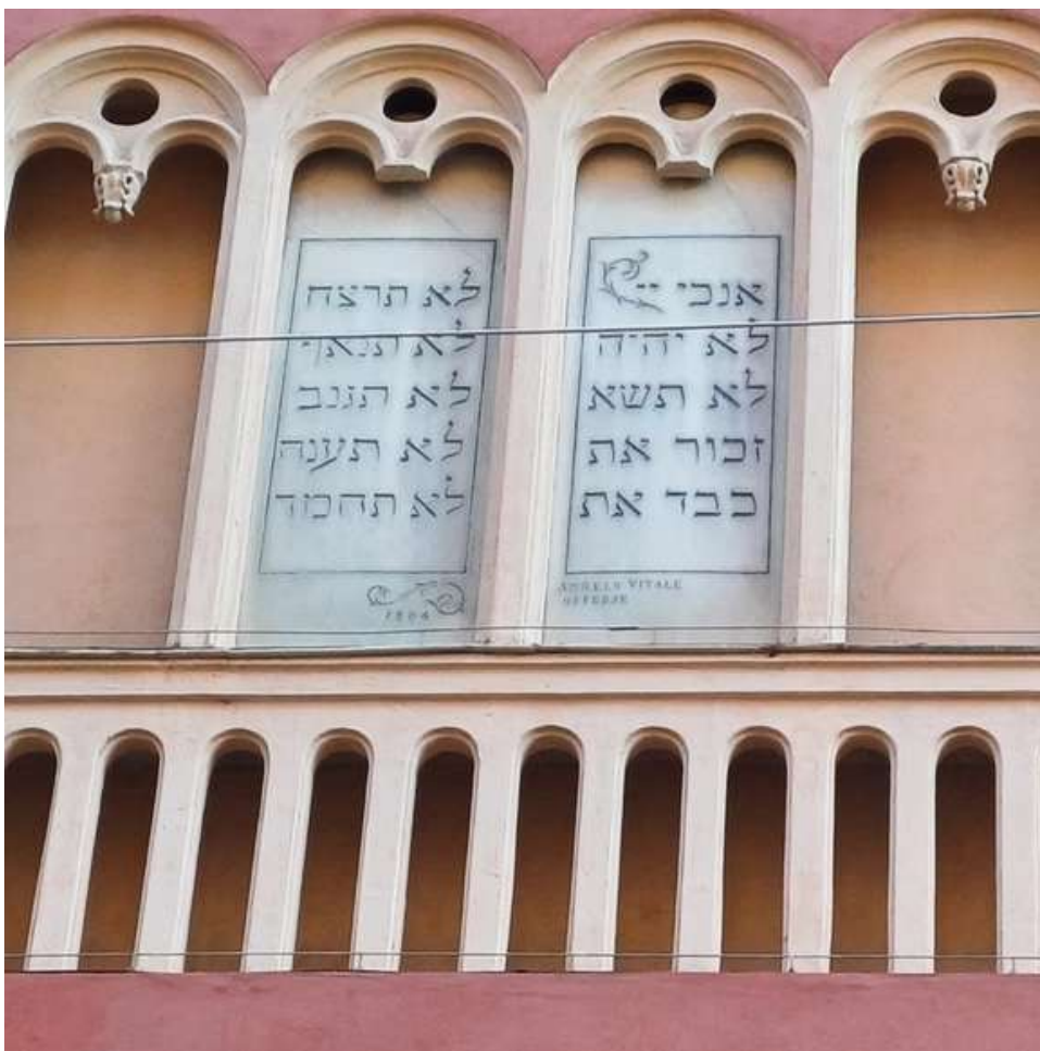
La Tavole della Legge sulla facciata della Sinagoga di Alessandria, nel centro storico della città
