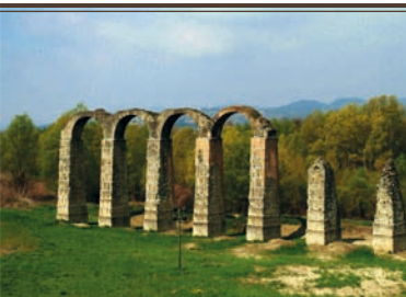
1 Acqui Terme: acquedotto romano
