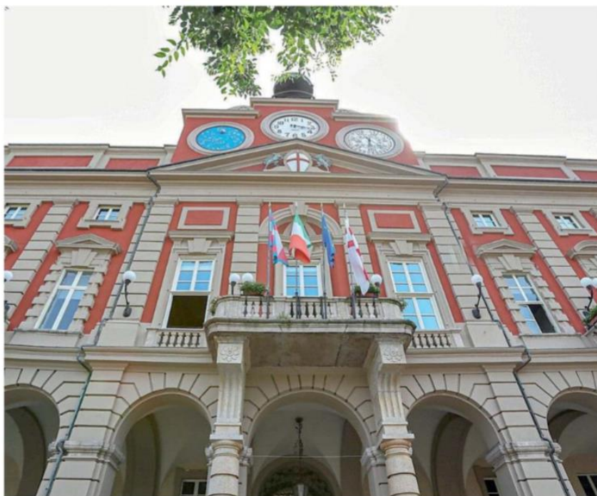
Palazzo Rosso, municipio di Alessandria, è uno degli edifici simbolici della città capoluogo di provincia
