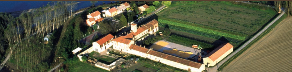
1 Ortsteil Torre Isola
