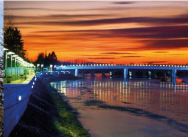
8 Brücke über den Tanaro
